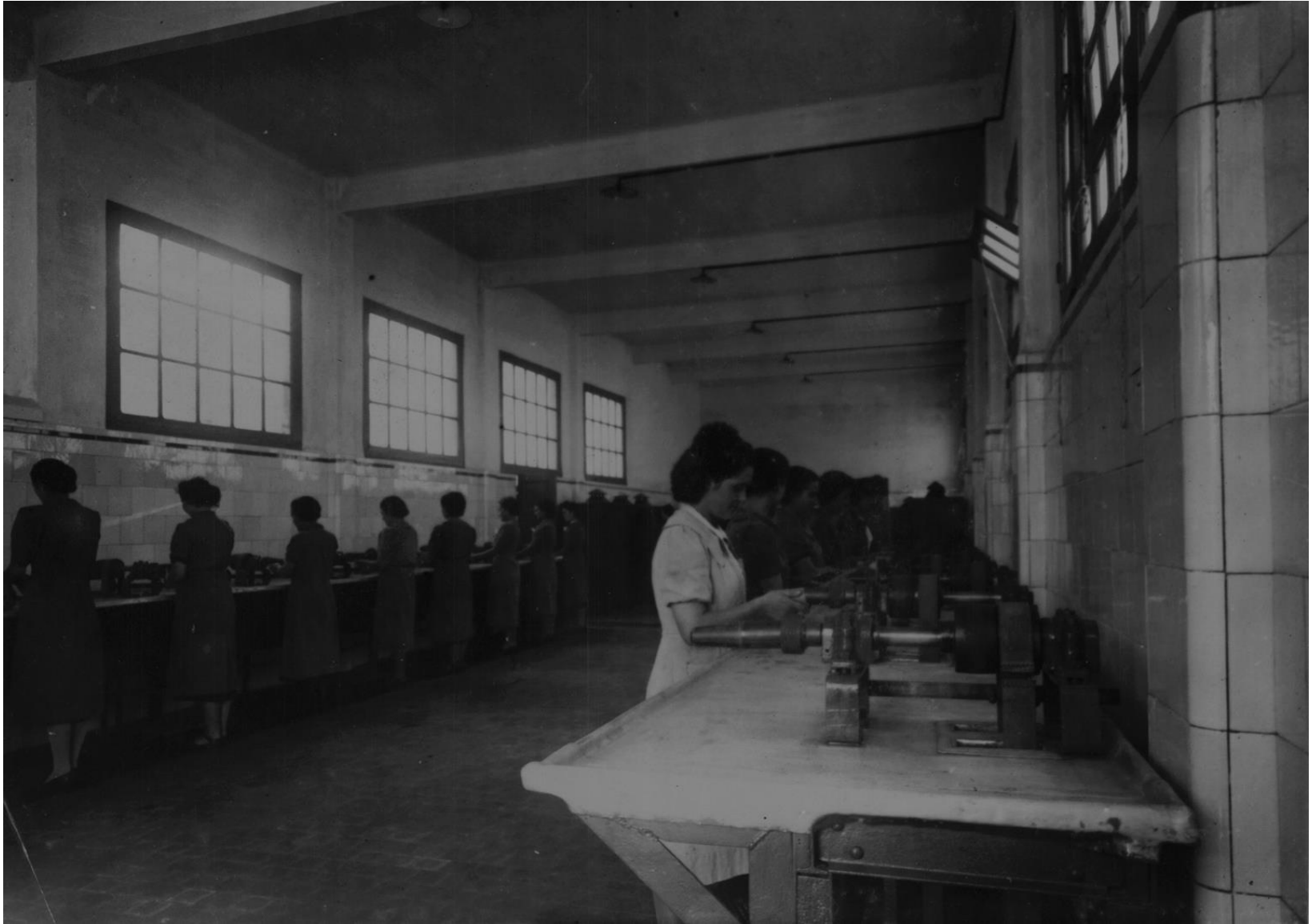
1940's. Operación de carga manual en el taller de fabricación.
